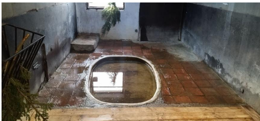
Работы по обустройству бассейна тапиров
