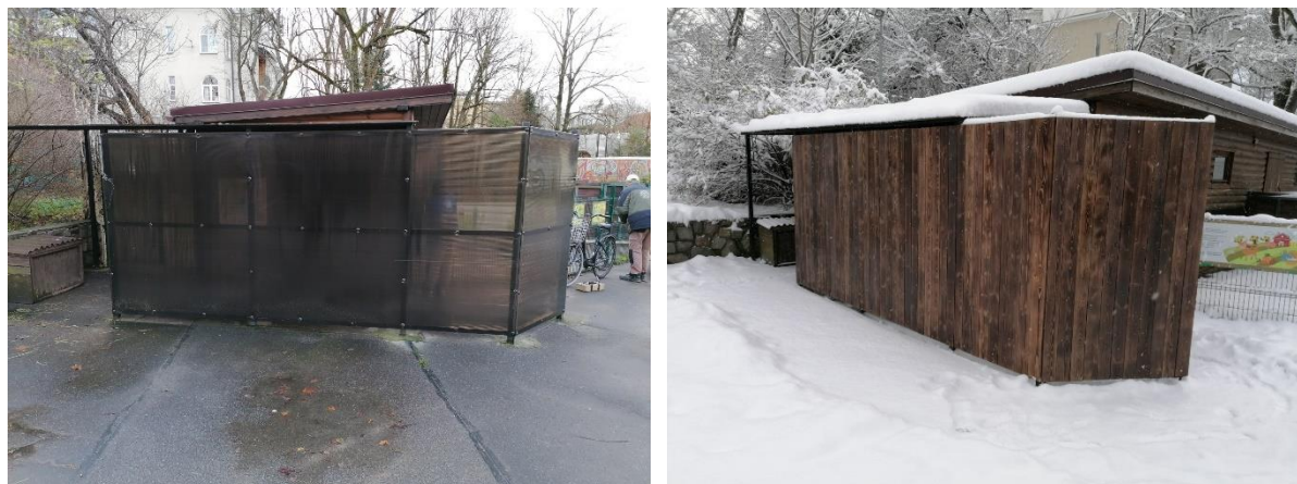
Теневого навеса до производства работ и после обшивки деревом
