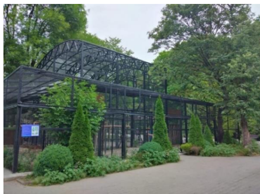
Перед началом выполнения работ
