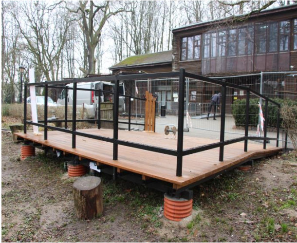
До начала работ
