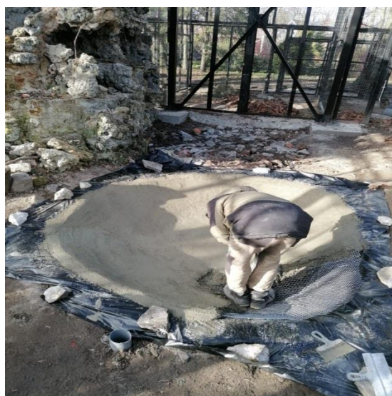
Заливка тела бассейна
