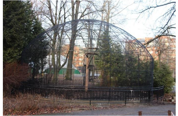
Вольер после реконструкции
