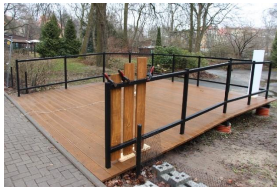
После установки площадки
