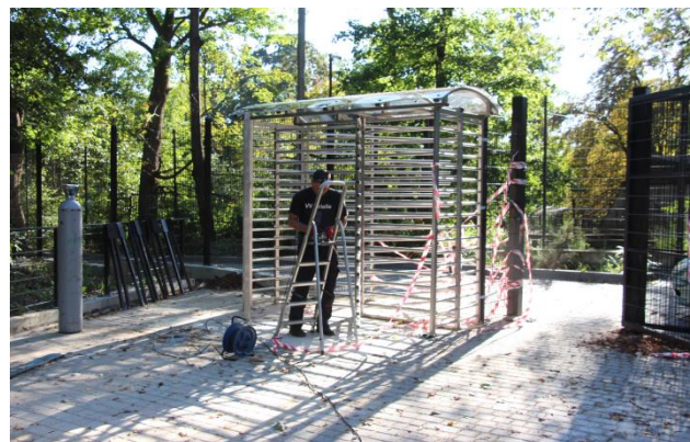
Полноростовой турникет, рассчитанный на выход с территории благоустройства, в том числе для ММГН
