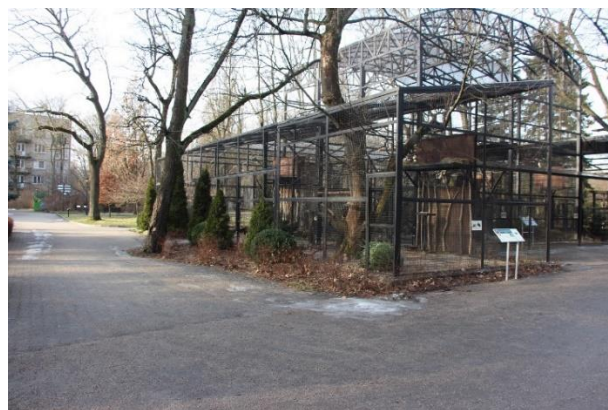
После выполнения работ
