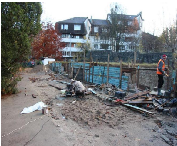
Работы по демонтажу
