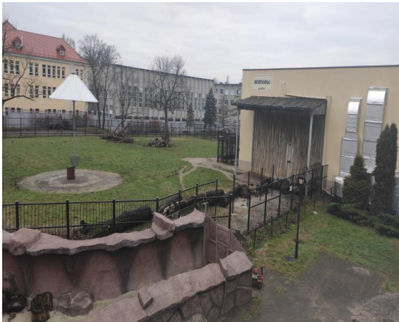
До выполнения работ
