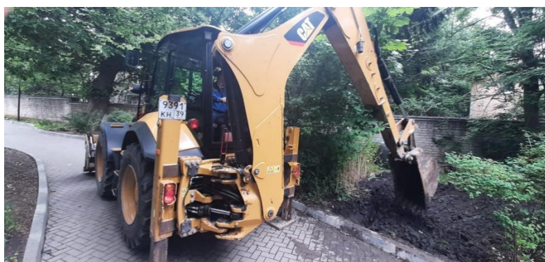
Поиск утечки на водопроводной сети
