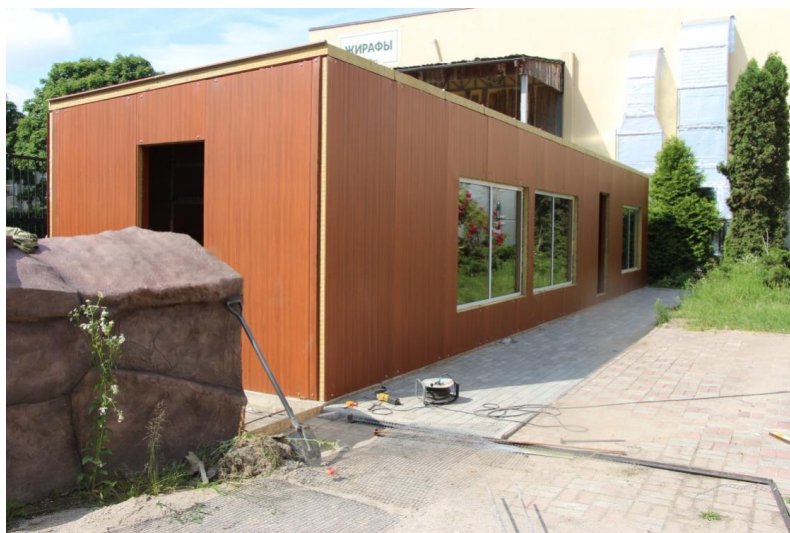
Зимний вольер сурикатов после установки модульного сооружения
