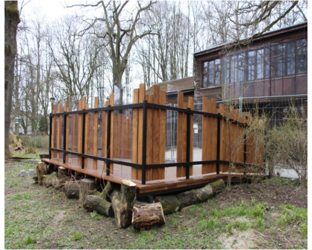
Установленное ограждение площадки
