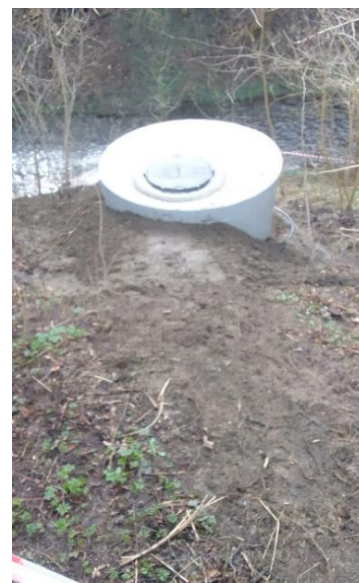
Установленный колодец
