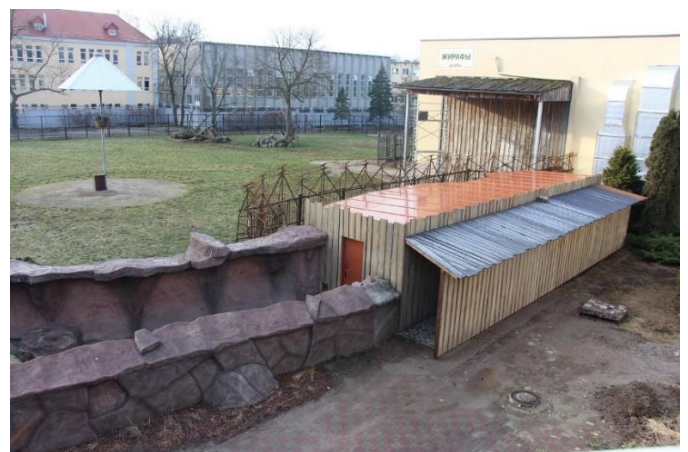
После завершения работ
