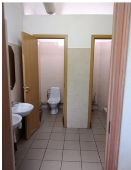
До выполнения работ
