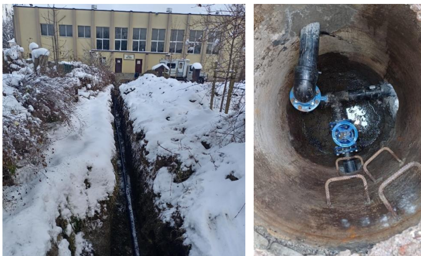
Замена аварийного участка трубопровода
