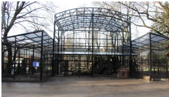
До начала выполнения работ
