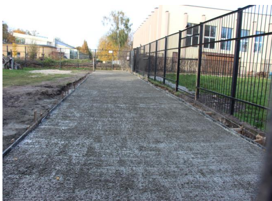
Площадка после завершения работ
