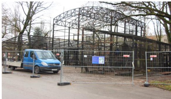
После монтажа покрытия
