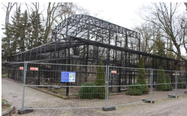
После выполнения работ
