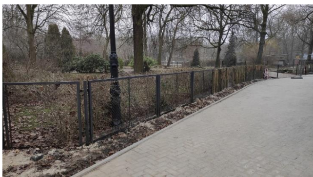
Ограждение до демонтажа
