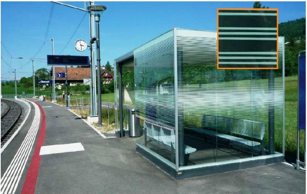
Новый стандарт для зоны ожидания на станциях Федеральных железных дорог Швейцарии. В нижней части стекла маркировка отсутствует, т.к. функцию снижения видимости выполняет находящаяся внутри мебель.
