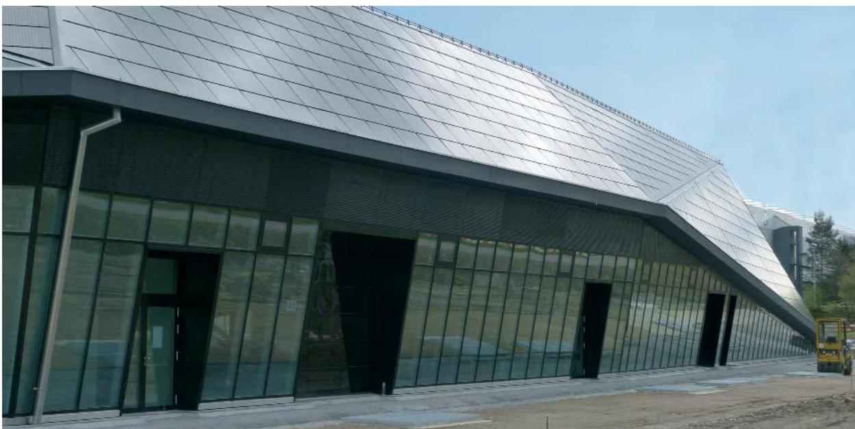
Этот уникальный дизайн большого зала включает в себя крышу из солнечных панелей, которая спускается на фасад. Степень, в которой наклонные поверхности окон
