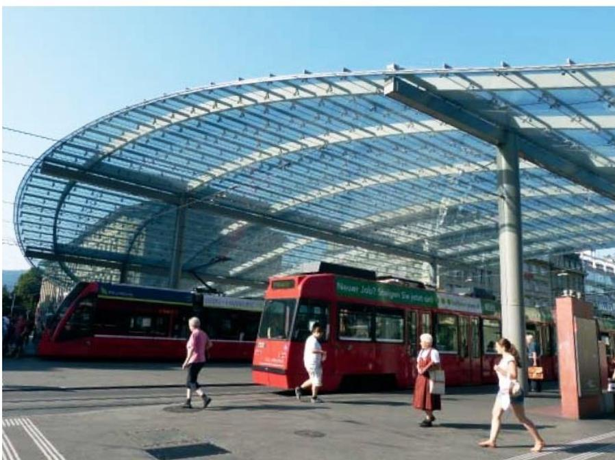
Такие стеклянные навесы в значительной степени беспроблемны. Остаточный риск может сохраняться по краям, которые имеют больший наклон. Благодаря нанесённой сетке точек, которая также обеспечивает защиту от бликов для прохожих, эта опасность также устраняется.
