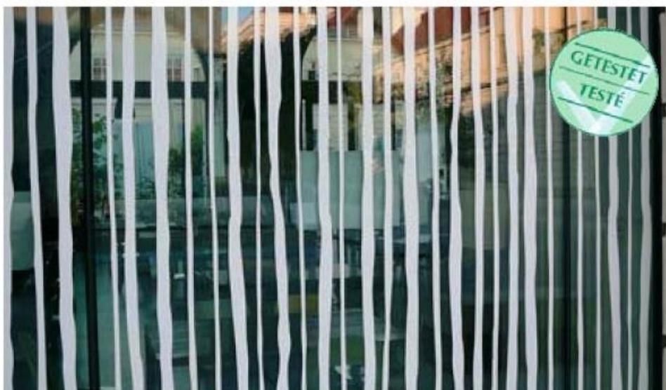
Линейная маркировка обеспечивает качественную защиту. Блестящая пленка обычно хорошо выделяется на фоне.
