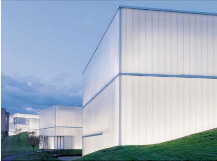
Светоотражающие изоляционные панели в двухслойном U-образном стекле позволяют использовать дневной свет и значительно уменьшать потери тепла. Они обеспечивают оптимальное равномерное излучение света в помещении.
