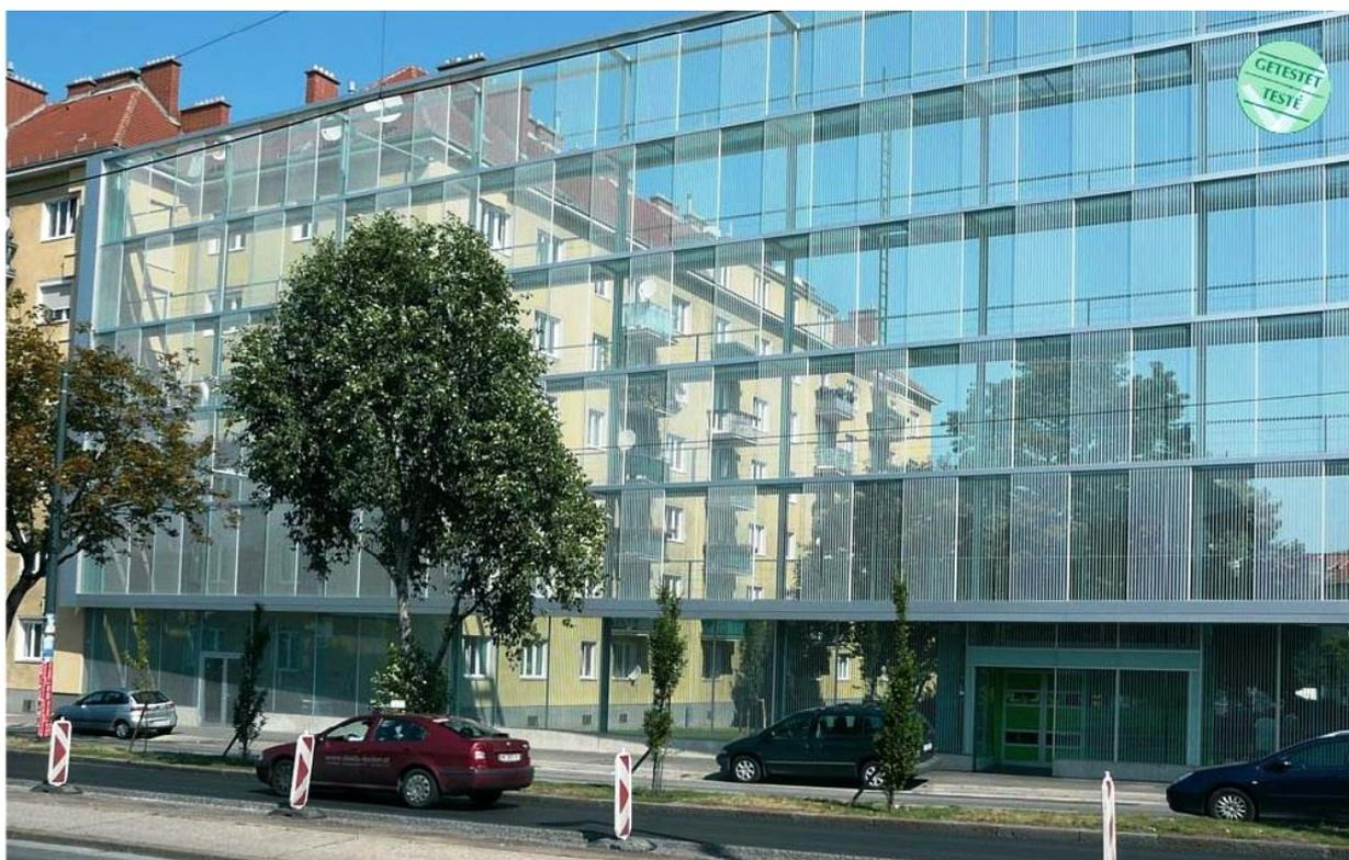
Этот шумоизолирующий барьер в районе Theodor-Körner-Hof в Вене был построен в 2009 году для защиты и модернизации шумного жилого квартала. Это образцовый пример защиты птиц, тем более, что применяемые структуры вначале прошли испытания и были признаны максимально эффективным и успешным решением проблемы столкновения птиц со стеклянными поверхностями.
