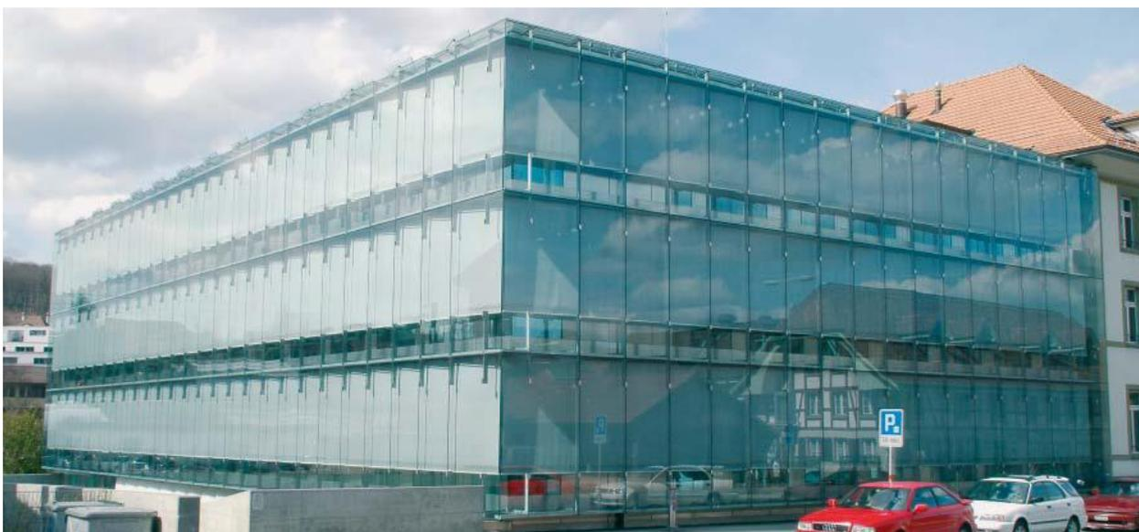
Внутренняя система затенения интегрирована в стеклянный фасад. Отражающая способность материала всё ещё сохраняется, более того, она несколько усиливается в зависимости от угла падения света. Тем не менее, благодаря яркому материалу затемняющей ширмы, уровень отражения довольно сильно ограничен.
