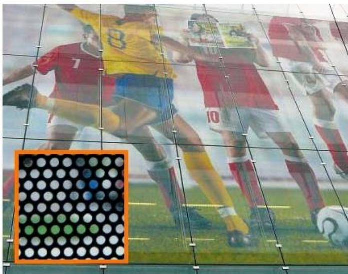
При помощи фолки можно декорировать «на заказ» целые фасады. В таких случаях обычно используется плёнка с перфорацией, что обеспечивает определенную прозрачность.
