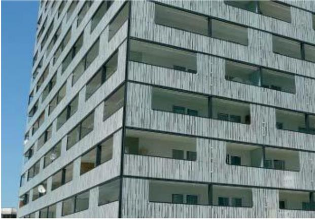
Трафаретная печать обеспечивает жителям дома видимость с террасы и делает видимыми общий объем и структуру здания.
