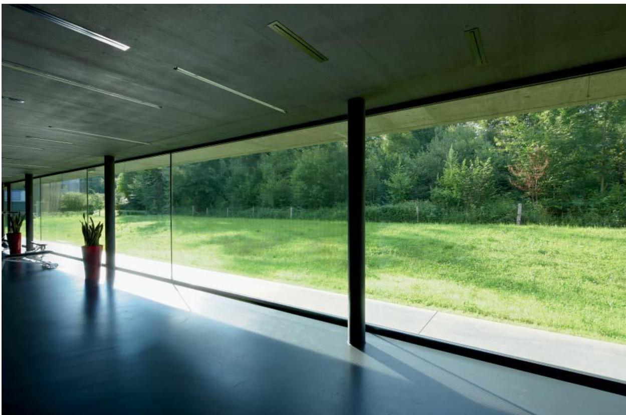
В этом спортивном зале Швейцарский союз наблюдателей за птицами проводил вышеописанные тесты. Параллельно кромке леса устанавливались обычные и экспериментально маркированные стёкла. При нанесении специальным методом на внешнюю сторону стекла полоски создают эффект «мутного стекла». При нанесении с внутренней стороны эта маркировка малоэффективна. Этот продукт можно использовать в тех случаях, когда необходимо солнцезащитное стекло с высокой степенью отражения.
