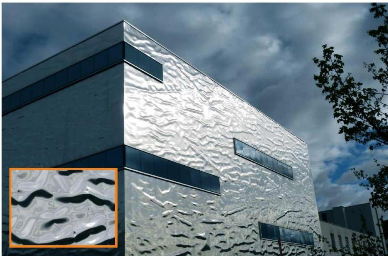
Хотя это складское здание покрыто металлическим материалом, обладающим высокой отражающей способностью, благодаря выраженным выпуклостям и неровной поверхности оно должен быть безопасным для птиц.
