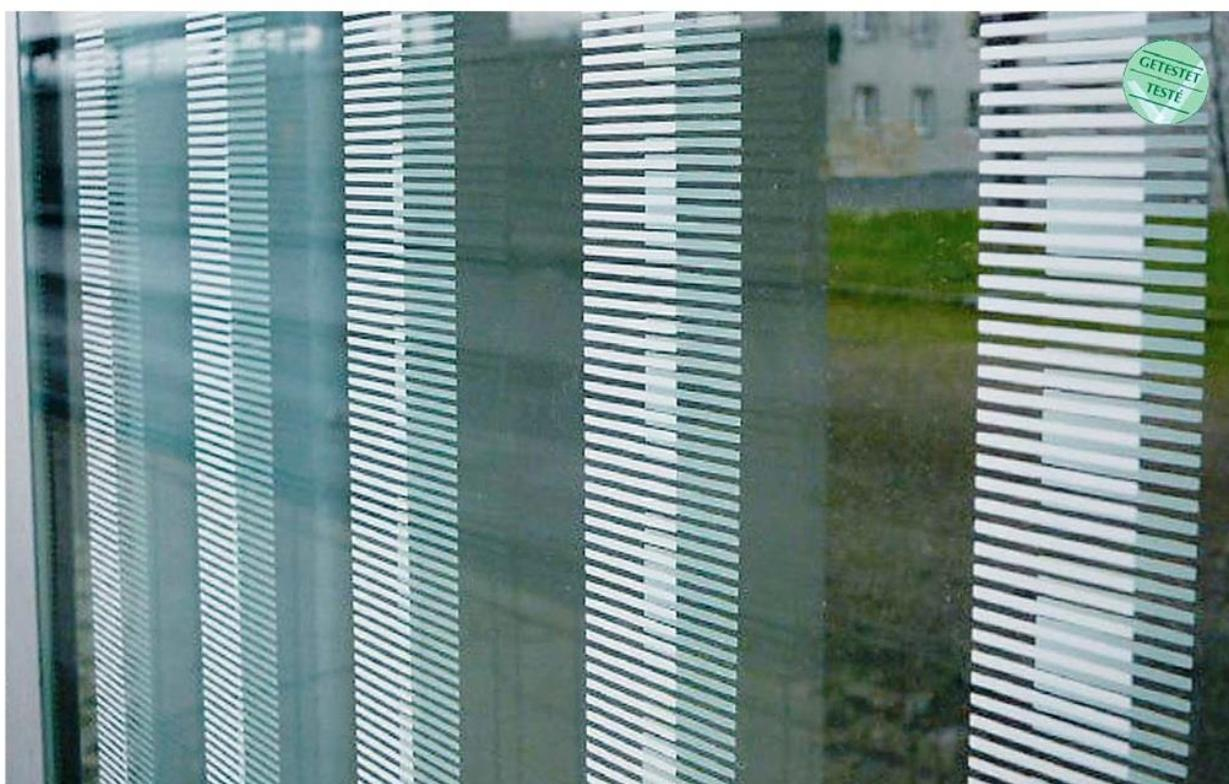
Деталь вышеуказанной стены. Трафаретная печать - прерывистые полосы шириной 2 см на расстоянии 10 см – нанесены с обеих сторон стекла, причём с задней стороны они немного шире, что увеличивает 3D-эффект при приближении к поверхности.
