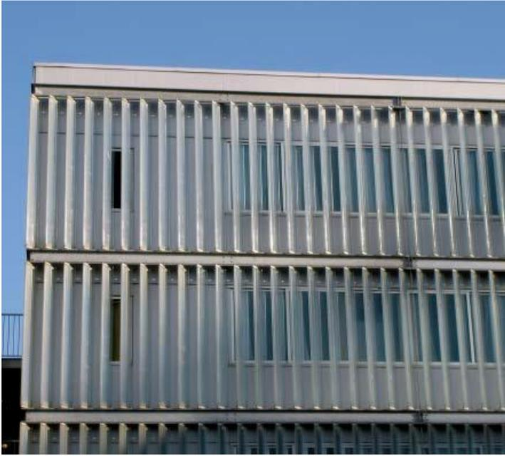
Пилястры («разделители») и вертикальные или горизонтальные ламели создают тени и разделяют фасад. В случае их закрепления на столь небольшом расстоянии, как на этом фоне, опасность может быть немного выше.
