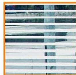
Навесы автобусных остановок, небольшие шумовые барьеры, оконные стёкла, балконные балюстрады и т. д. также могут быть модернизированы при помощи горизонтальных или вертикальных полосок. В данном случае стеклянные панели, из которых изготовлена эта остановка в Мюнхене, были запечатаны орнаментом с самого начала.
