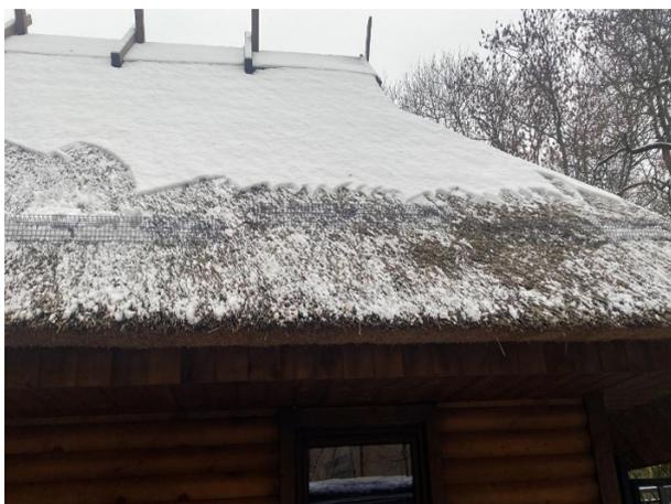
*Кровля вольера Г 23 оборудованная устройством для снегозадержания*
