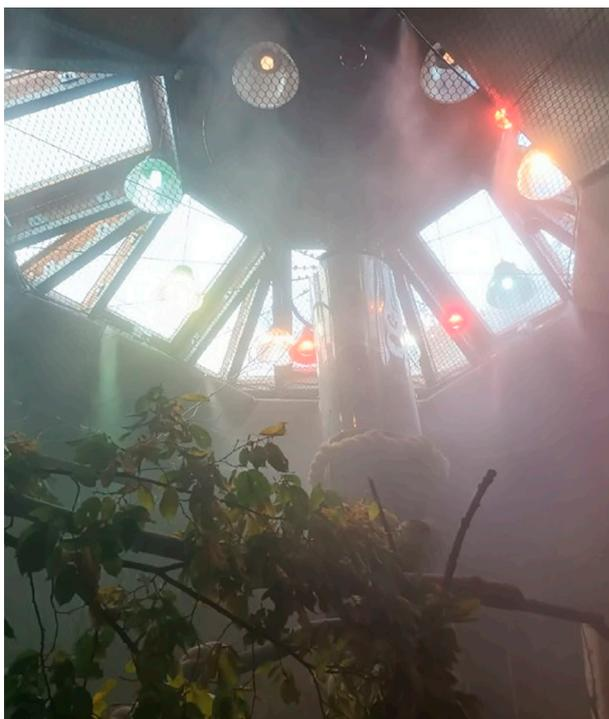
Для обитателей тропического леса ленивца и броненосца в вольере был установлен генератор тумана, позволяющий создать необходимые климатические параметры. Автоматическая система климат-контроля заменила маломощные бытовые увлажнители, которые ранее использовались в вольере, но с трудом справлялись с поддержанием требуемого уровня влажности.
