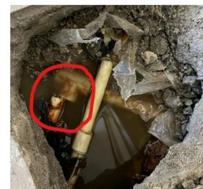
*Ремонт систем отопления – вскрытие полов*
