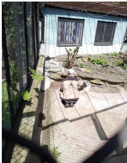
*Нанесение гидроизоляции на русла водопадов в вольерах винторогих козлов*
