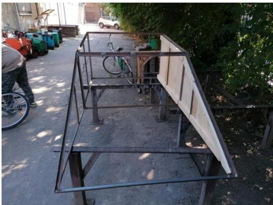
*Металлический каркас трапа*
