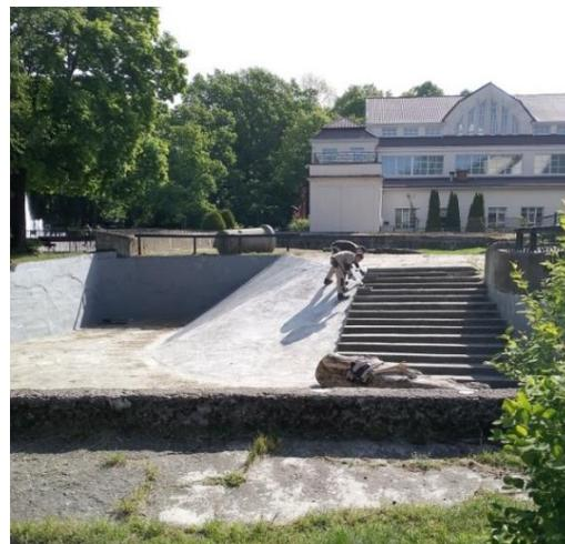
*Нанесение гидроизоляции на поверхность фонтана*
