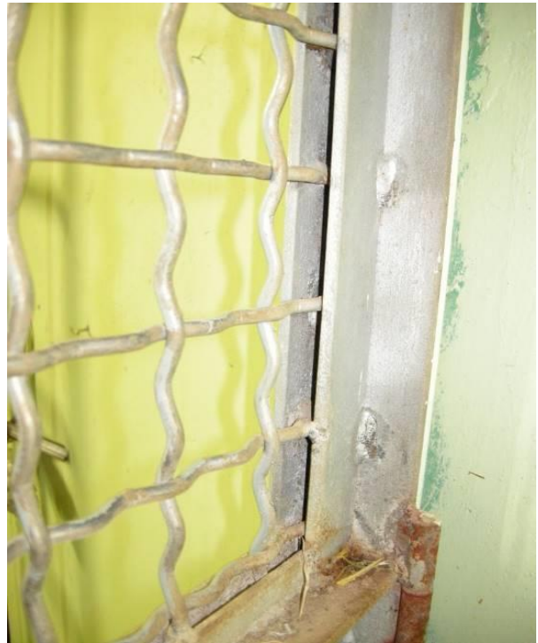
Волнистая сетка, приваренная между двумя стальными профилями
